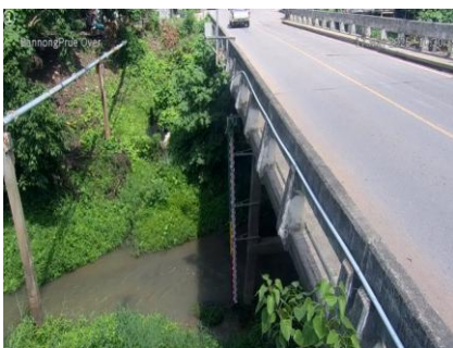
สะพานบ้านหนองปรือ - อ.หนองปรือ จ.กาญจนบุรี (ลุ่มน้ำแม่กลอง)
