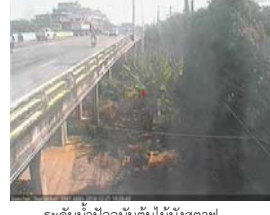
สะพานข้ามแม่น้ำท่าจีน ทางหลวง365 อ.สามชุก จ.สุพรรณบุรี (ลุ่มน้ำท่าจีน)
