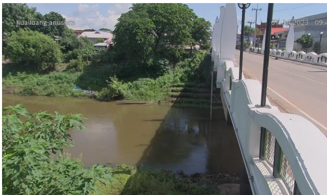
TC031703 : สะพานห้วยหลวงอนุสรณ์ ต.จุมพล อ.โนนพิสัย จ.หนองคาย
