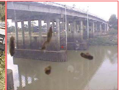
สถานีสตึก.สตึกอ.สตึก จ.บุรีรัมย์ (ลุ่มน้ำมูล)
