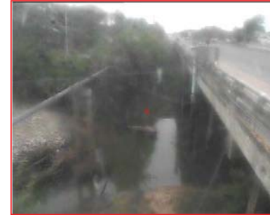
สถานีห้วยหลวง ต.หม่ม อ.เมือง จ.อุดรธานี (ลุ่มน้ำโขง)
